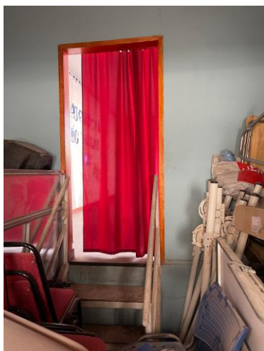
Bodega Escenario, estado actual.
